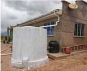
Permite acumular un mayor volumen de agua, en comparación con otros sistemas. Al ser un sistema cerrado, existe menor riesgo de contaminación por microorganismos
