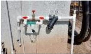
Dispositivo que se utiliza para distribuir el agua de riego de manera uniforme y controlada, puede utilizarse para aplicar fertilizantes sistémicos, técnica denominada fertirrigación.
