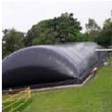
La planta de biodigestión genera la energía y recuperación de nutrientes a través de la digestión anaeróbica de los residuos orgánicos generados por la actividad agrícola e industrial.
